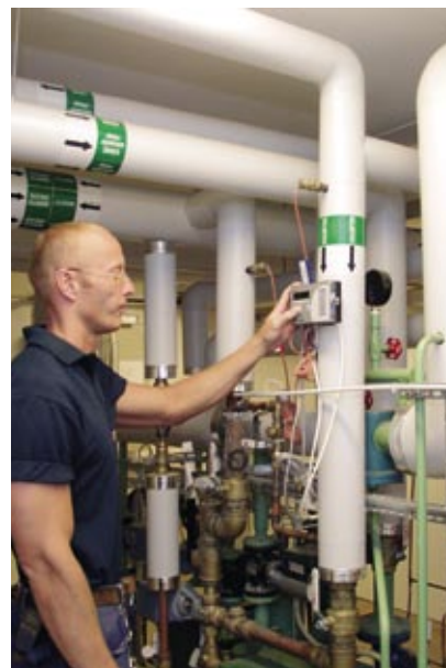
Системами отопления и водоснабжения легко управлять, когда трубы изолированы надлежащим образом.
